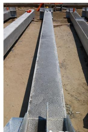
Fig.10: Sezioni partially encased con calcestruzzo ordinario in fase di allestimento in cantiere
