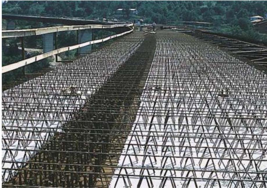
**Fig. 4** Esempio di impalcato da ponte a struttura mista acciaio-calcestruzzo
